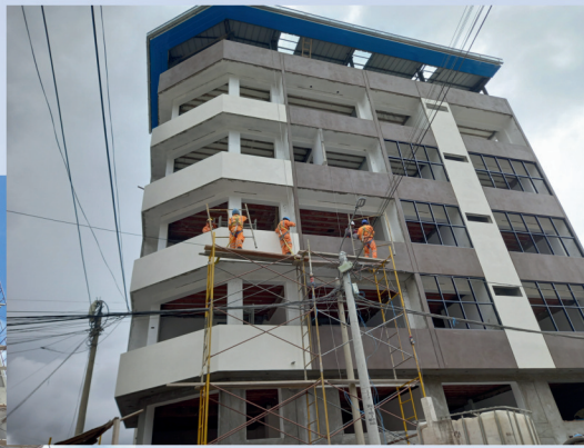
Aplicación de Microcemento Cerro de Pasco
